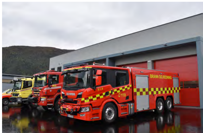
Onsdag 27.09 var det offisiell overtagelse av den nye brannstasjonen på Åndalsnes. Bygget, som er på rundt 2250 kvadratmeter, er utformet med særskilt vekt på logistikk og skille mellom ren-uren sone (Foto: Endre Dahlen/NORBR)
