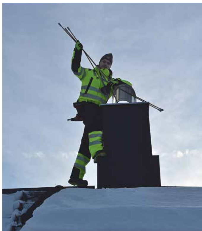
Pål-Henrik Karlsen klargjør for fresing av pipeløp. (Foto: NORBR/Endre Dahlen)
